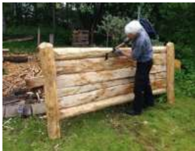
Arbejdet med bolværk. Kanhavekanalen.
