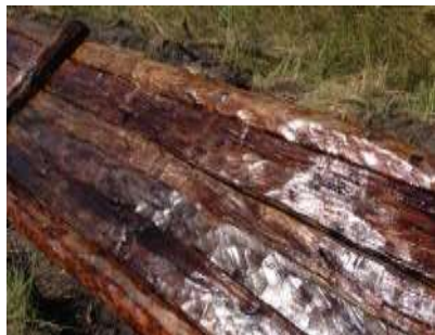
Stålskib og Bolværk. Kanhavekanalen.
